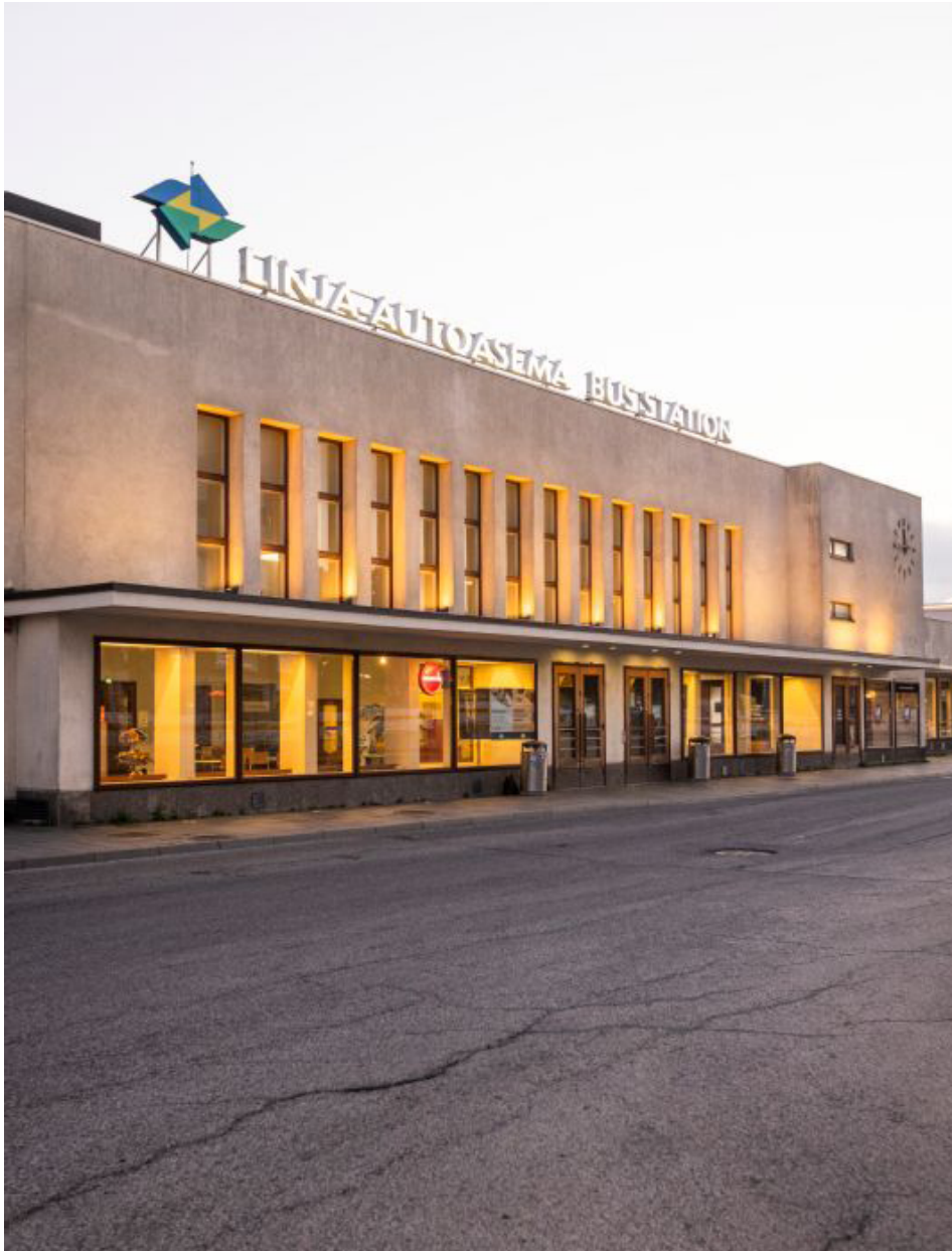
Yllä: Tampereen linja-autoasema. Vapriikin kuva-arkisto. 2021. Vieressä oikealla: Kortteli 191 korostettuna. Google / Tundra Architecture Oy. 2024.
