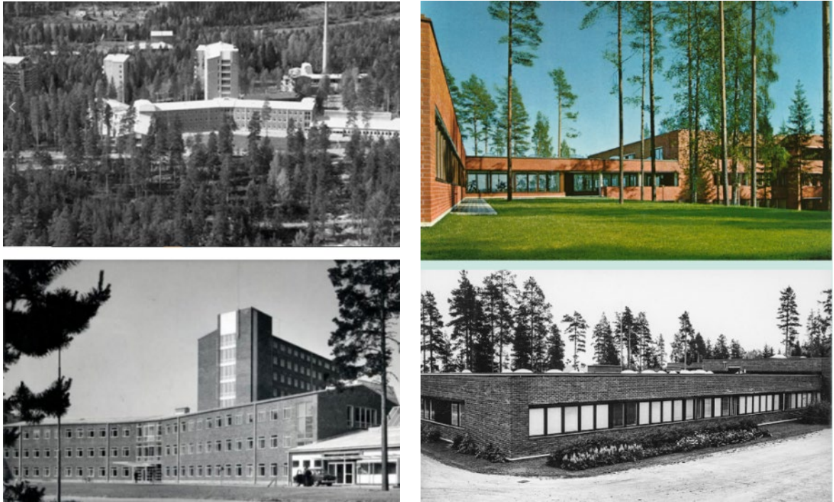
Vasemmalla sairaalarakennuksia 1950-luvulla ja oikealla entisen sädesairaalan rakennuksia 1970-luvulla (Lähde: K-S museo ja Sairaalamuseo)
