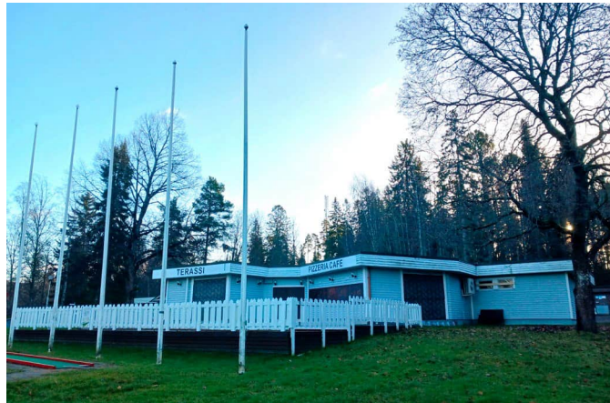
Leirintäalueen vastaanottorakennus / ravintola.
