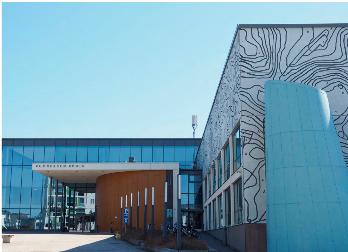
Kuva 4.21. Vuoreksen koulu. Julkisivutaide: Olet tässä, Tomas Byström 2013.
