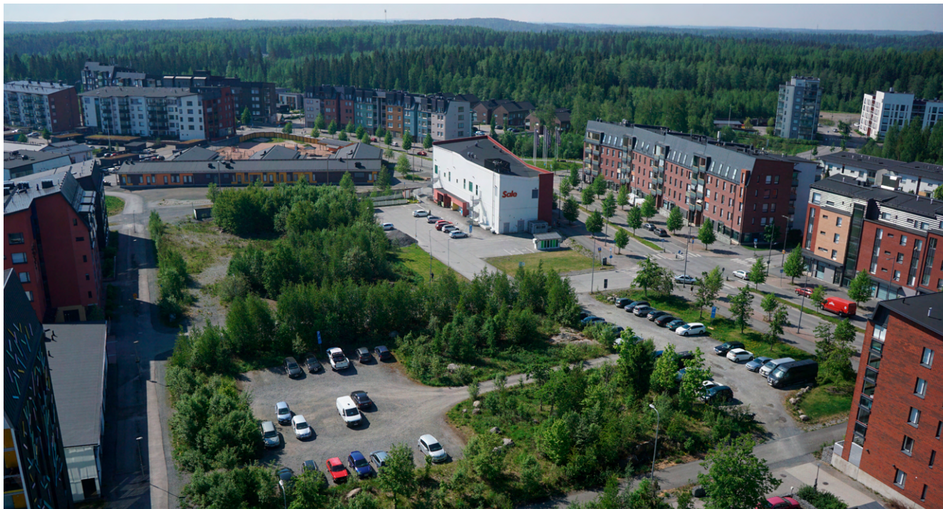
Kuva 4.8. Ilmakuva kohti etelää. Rakentumattomat keskustakorttelit ovat osittain kasvillisuuden peitossa.
