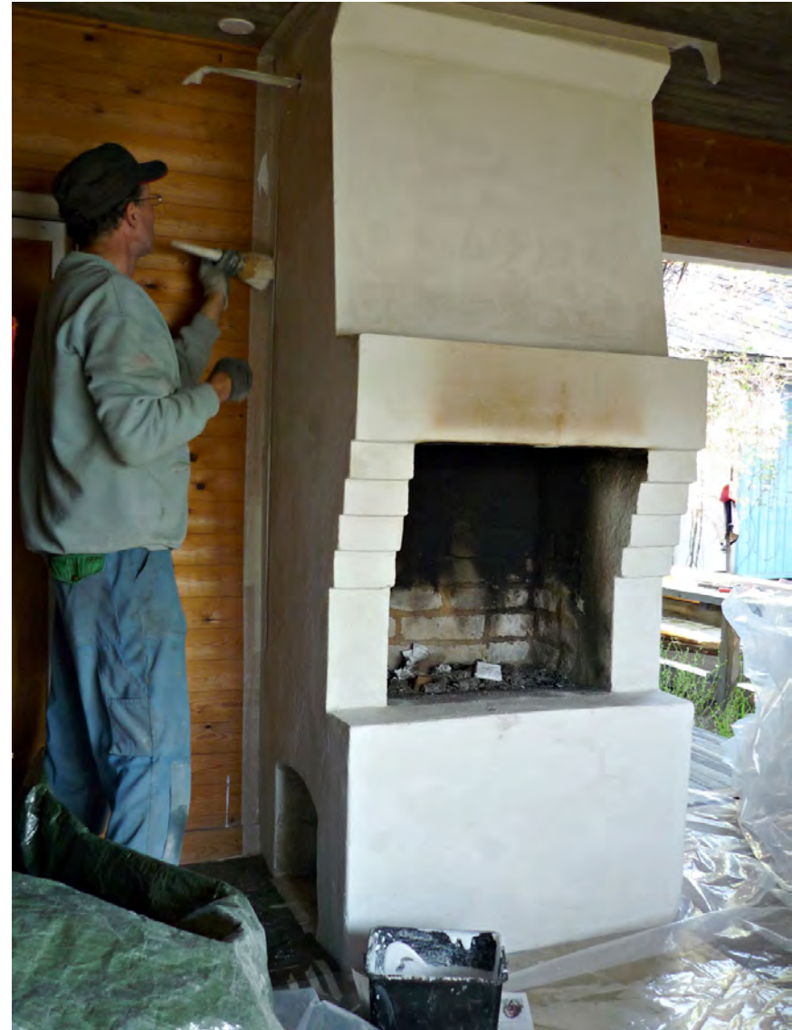
Työhuoneen uunista paikattiin yksi kolhu, ja työhuoneen ja salin uunit kalkittiin kertaalleen Hyvinkään betonin kalkkimaalilla.
